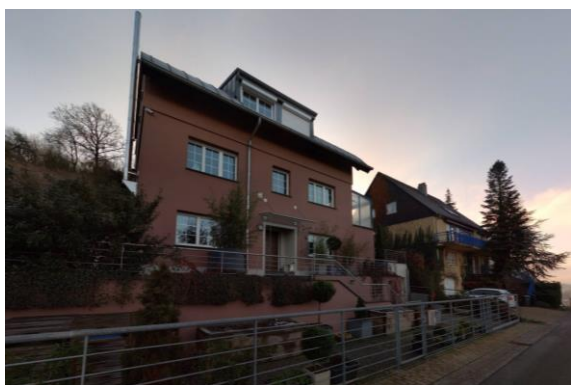
N° 32, Rue Belle-Vue, située à l'Est du site
