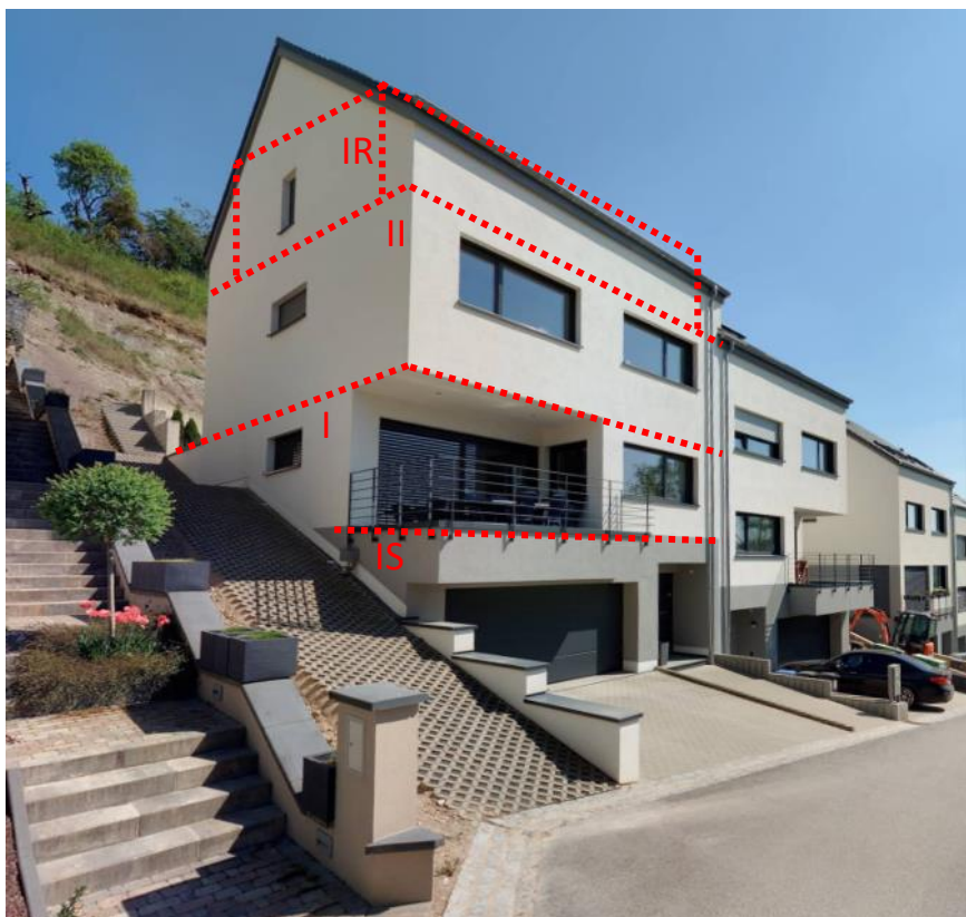
Maison n° 26A, Rue Belle-vue à Lorentzweiler.
