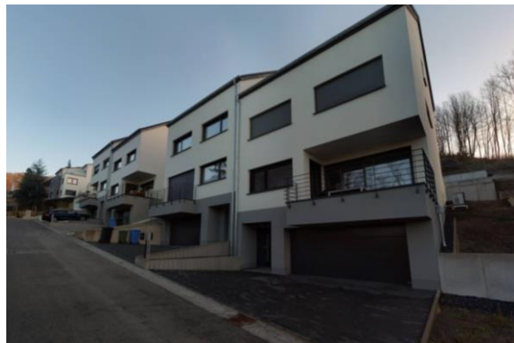
N° 24 et 24A, Rue Belle-Vue, situées au Sud-Est du site
