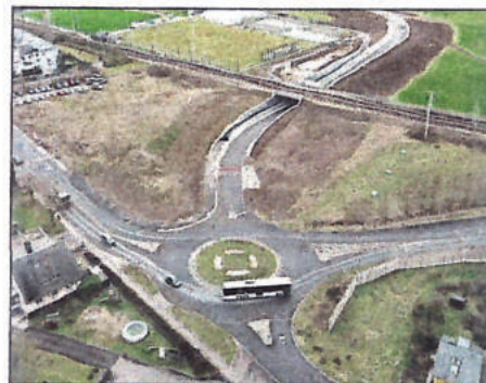
Die Umgehungsstraße führt unter der Eisenbahnlinie hindurch. Foto: G. Huberty
