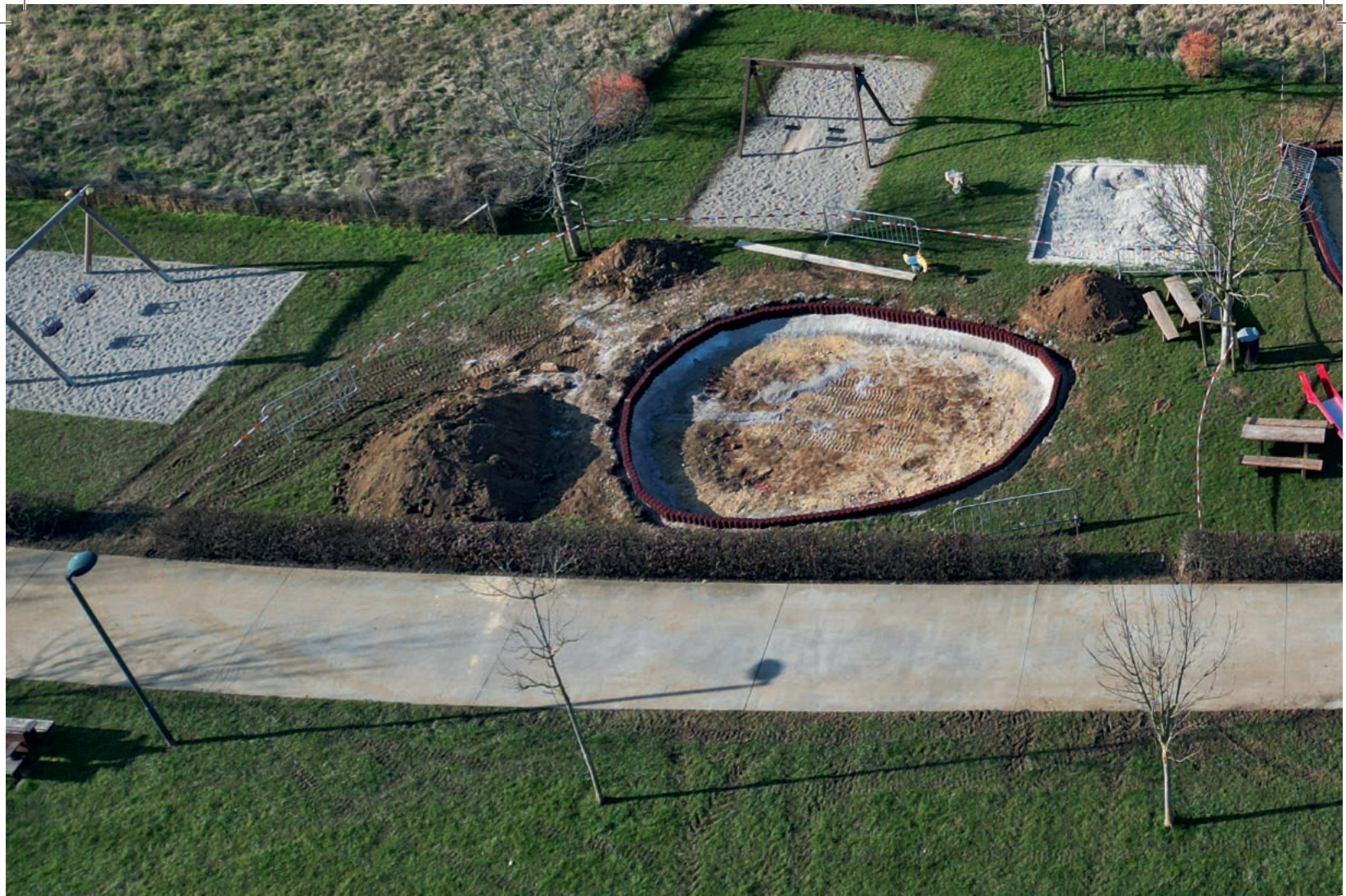
• Aire de jeux Hunsdorf en rénovation
